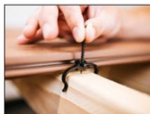
1. Sul bordo esterno della doga installata per prima, collocare l'EDGECLIP™ sul travetto consentendo alle "estremità" della clip di afferrare saldamente il travetto e tenere la clip della doga installata per prima e quindi collocare l'EDGECLIP™ sul travetto consentendo alle "estremità" della clip di afferrare saldamente il travetto e tenere in sede la clip.
