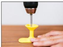
4. Tenendo saldamente in sede la nuova doga, avvitare tutte le clip tra le doghe. Usare la Guida gialla **Never-Miss™** (qui illustrata) in dotazione, per innestare completamente la punta del cacciavite sulla testa della vite per una rapida installazione.
