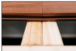
Installare sempre un doppio travetto ai giunti di testa. Usare una clip separata per assicurare ciascuna estremità della doga.
