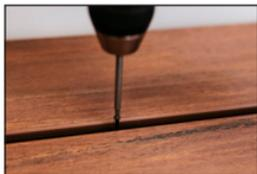
1. EDGECLIP™ e EDGEXCLIP™ consentono l'agevole rimozione o sostituzione di una doga. Iniziare svitando tutte le viti dal travetto che fissano la doga.
